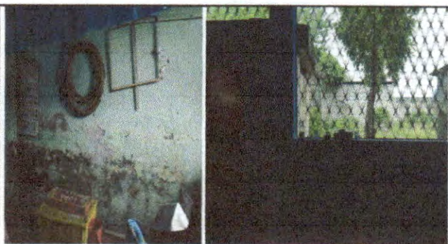
21.3 Alisado en muro (Aulas)
