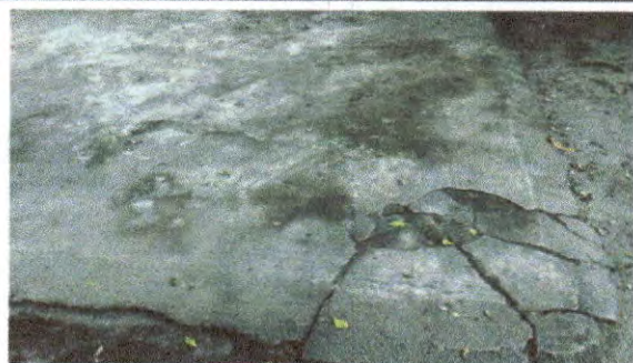
6.1 Reparación de piso de torta de concreto.
