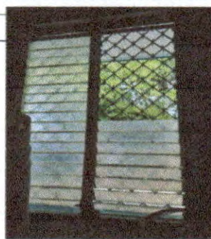
5.3 Sustitución de ventanas de aluminio por pvc
