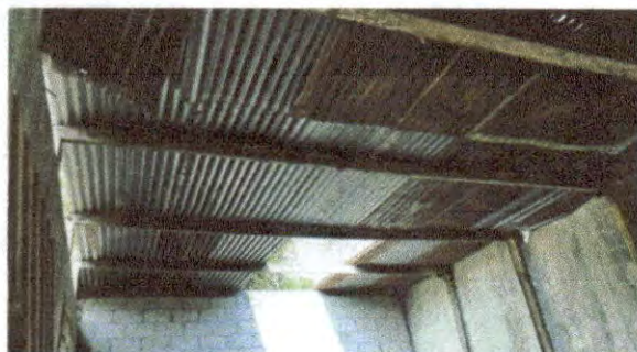
1.1 Sustitución de lámina, por lámina troquelada aluzinc calibre 26. (Aula)
